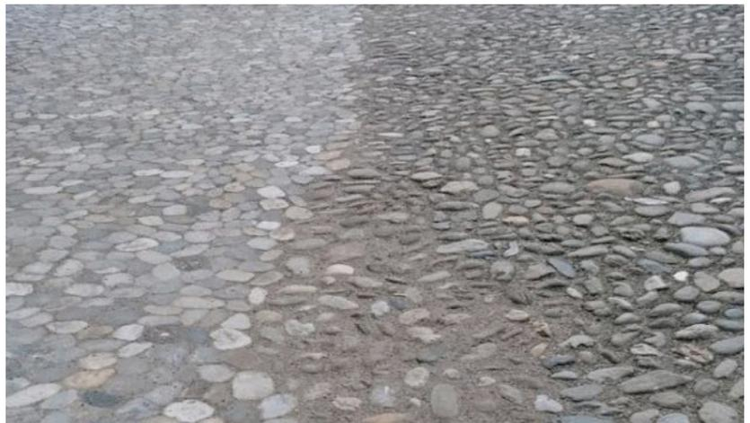
Durch Oberflächenschliff bearbeitetes Kieselplaster auf der Burg zu Burg-hausen: Der Verlust der plastischen Wirkung ist deutlich erkennbar.
