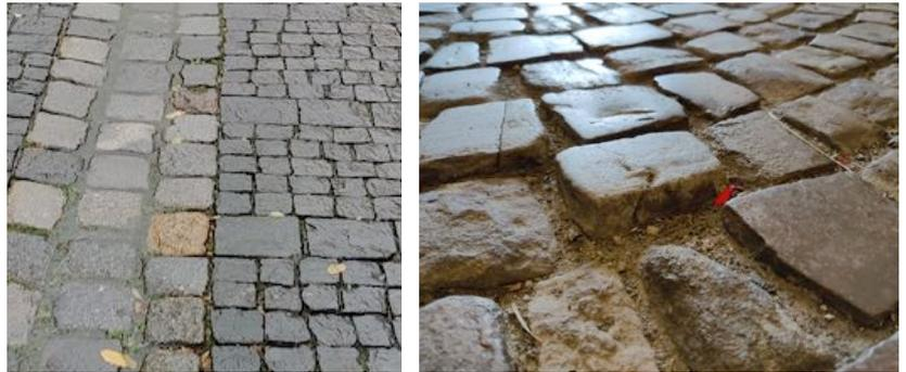
„Problematisches“ Pflaster: Belag am Oberen und Unteren Markt (links) und schadhaftes Pflaster im Bereich der Rathauspassage (rechts)
