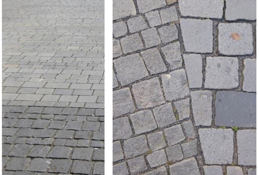
Zwei Beispiele zum direkten Vergleich von gesägtem und gespaltenem Pflaster in seiner jeweiligen gestalterischen Wirkung.
