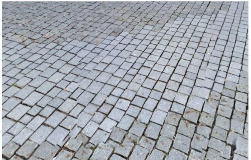
Rathausplatz Kempten: Bei gespaltenem Ausgangsmaterial ist der Verlust der plastischen Wirkung geringer. Es ist jedoch mit Aufhellungseffekten durch den Oberflächenabsliff zu rechnen.
