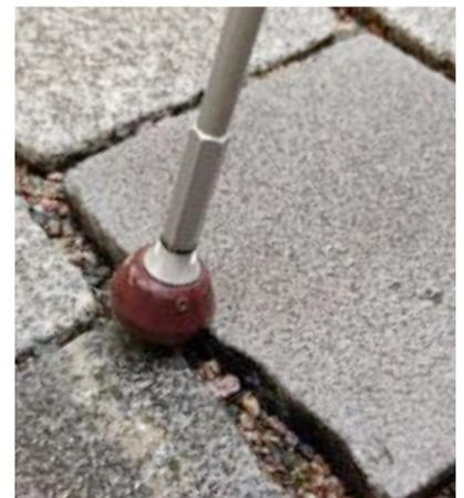
Bei grundsätzlich annehmbarem, ebenen Pflaster mit geschnittener Oberfläche ist die Breite und Tiefe der Pflasterfugen entscheidend für die Barrierefreiheit
